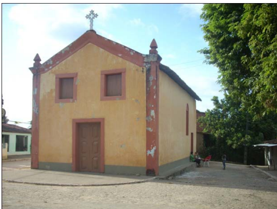
Figura 9 - Capela de Nossa Senhora do Rosário (1708). Fonte: Acervo LA/UFPE.
