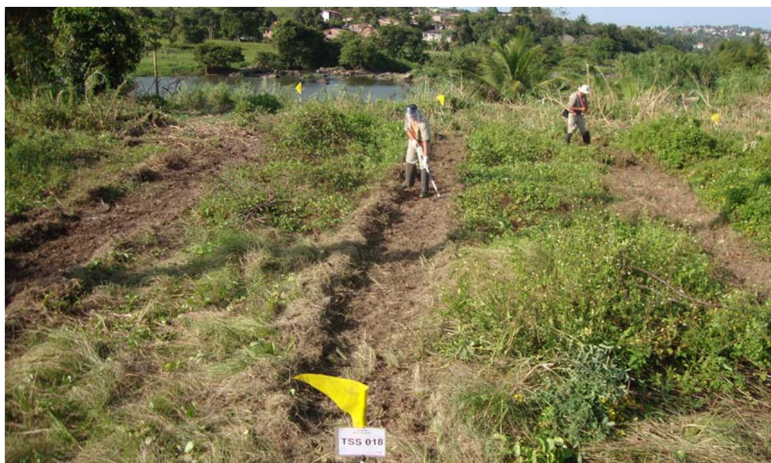
Figura 29 - Escavação e prospecção de TSSs.
