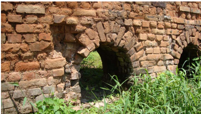
Figura 111 - Detalhe do material construtivo do forno.
