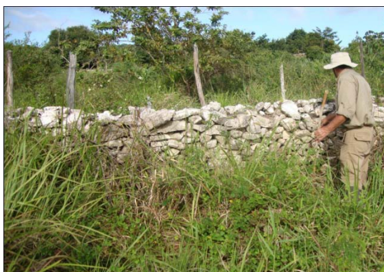
Figura 39 - Muro edificado com blocos de gesso. Reaproveitamento do material de bota-fora.
