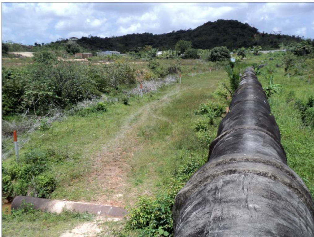
Figura 73 - Área de deposição coluvial com interferência antrópica: instalação da tubulação da Compesa.
