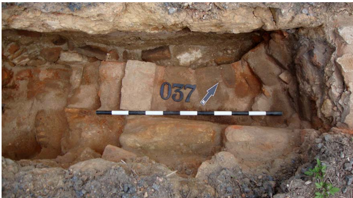
Figura 113 - Detalhe da curvatura da estrutura de tijolos “batidos” com argamassa de barro
