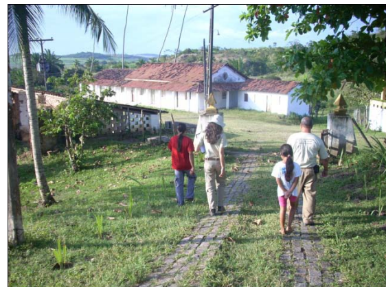
Figura 15 - Estrutura do Armazém do Engenho Tapacurá. Fonte: Acervo LA/UFPE.
