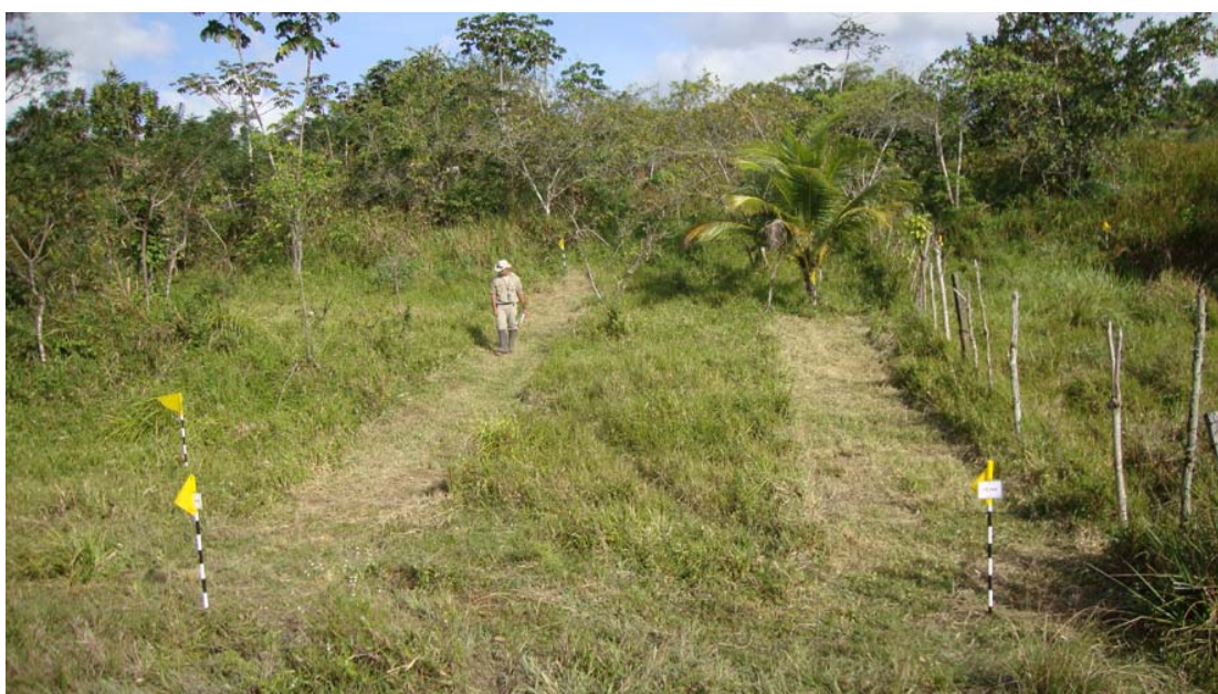
Figura 26 - Abertura de seqüência de trincheiras de superfície (TS) em área de encosta suave.
