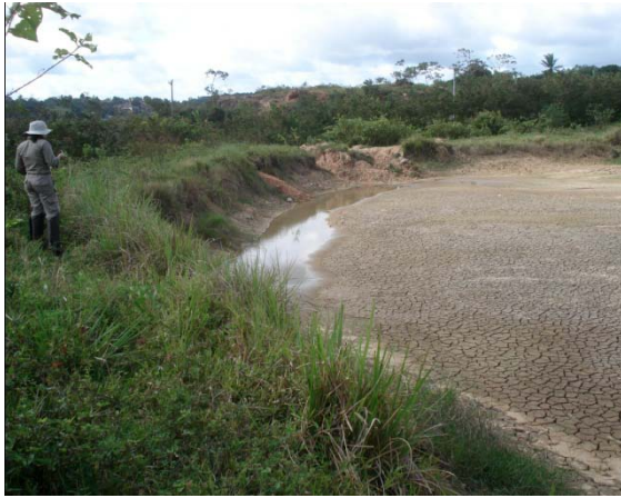
Figura 67 – Localização de açude escavado.
